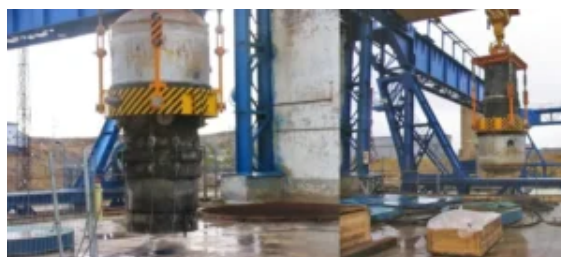
Reaktor BM-40A wyciągnięty z okrętu K-123
